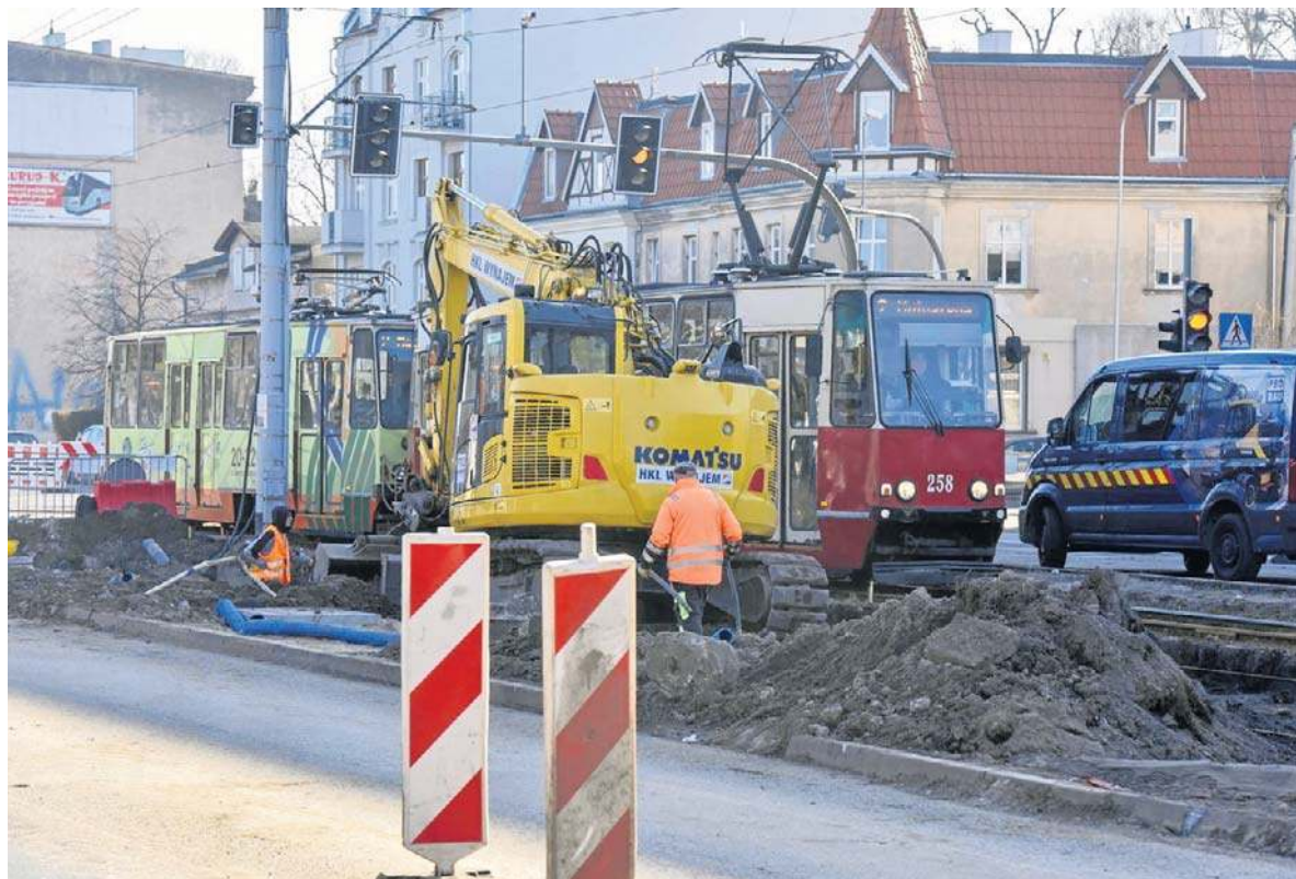
Przebudowa torowiska na ulicy Kościuszki ponownie nabiera tempa. Modernizacja trwa przy kursujących tramwajach - jeżdżą one wahadłowo jednym torem, a roboty obejmują drugi. I tak ma być do sierpnia tego roku
