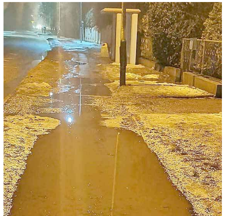
chodniki zalewane w drodze na Bema
