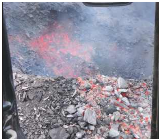
■ Stara Hałda jest zapożarowana co potwierdzają zdjęcia wykonawcy
