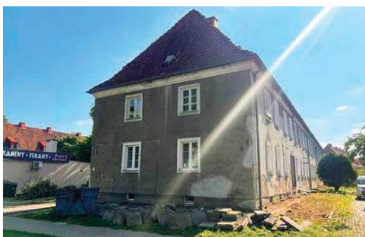
Blok przy ulicy Okrzei 5
