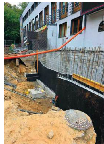
Intensywne prace przy ciechanowskim domu kultury
