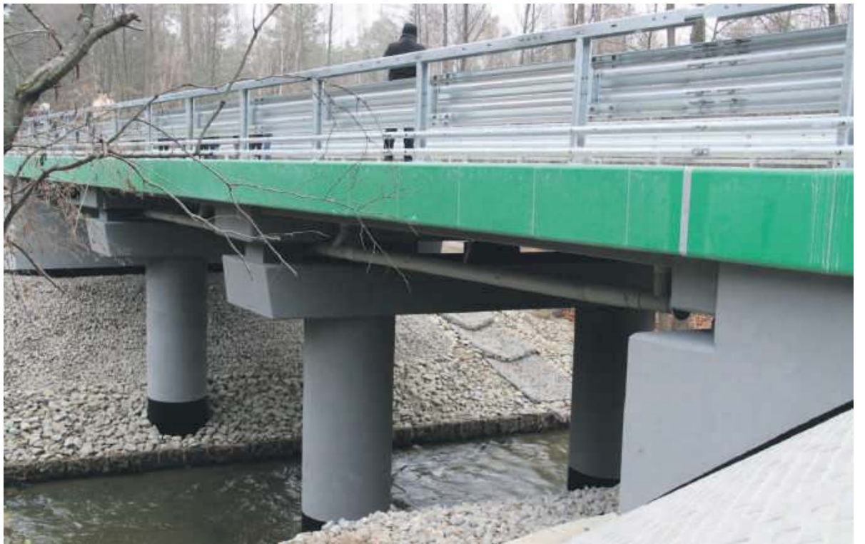
Przebudowana przeprawa ma nośność do 40 ton
