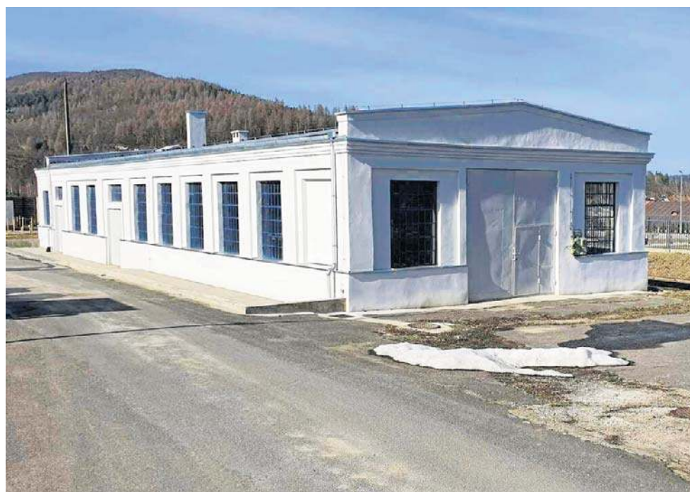
Stara kuźnia, która była w złym stanie, została wyremontowana. Po adaptacji wnętrza ruszy wytwórnia soków
