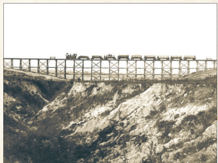
Pociąg na wiadukcie (Moście Janowickim) w Ruszowie koło Łabuń, 1915 r.
