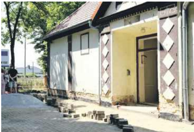
Przedszkole w trakcie remontu
