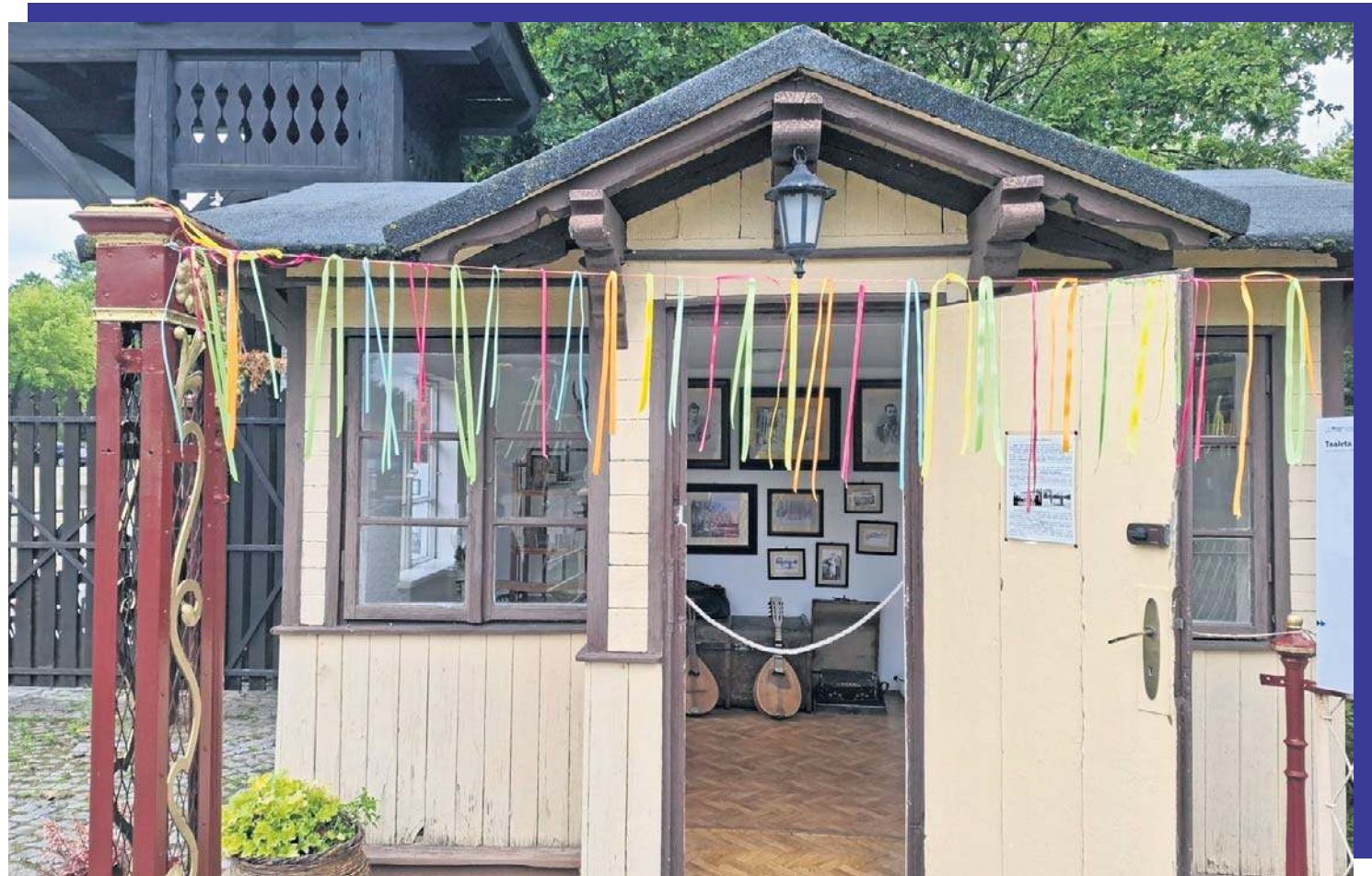
Budynek toalety stał pierwotnie w lasach spalskich.
