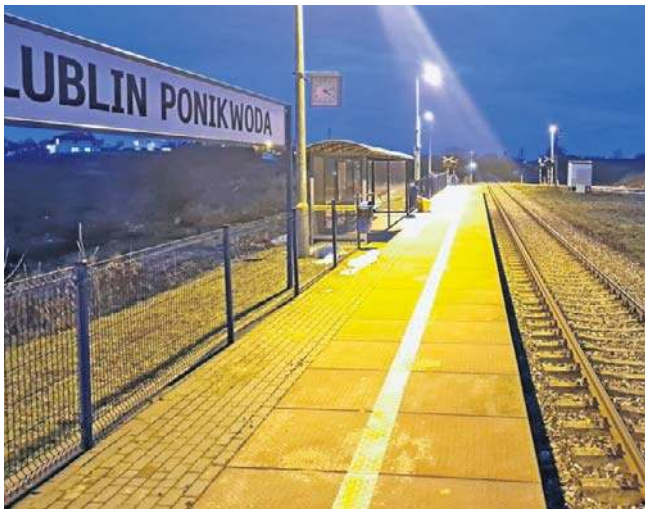
Droga do stacji i inne zmiany w układzie drogowym na Ponikwodzie zostaną ukończone najwcześniej w połowie 2027 r.
