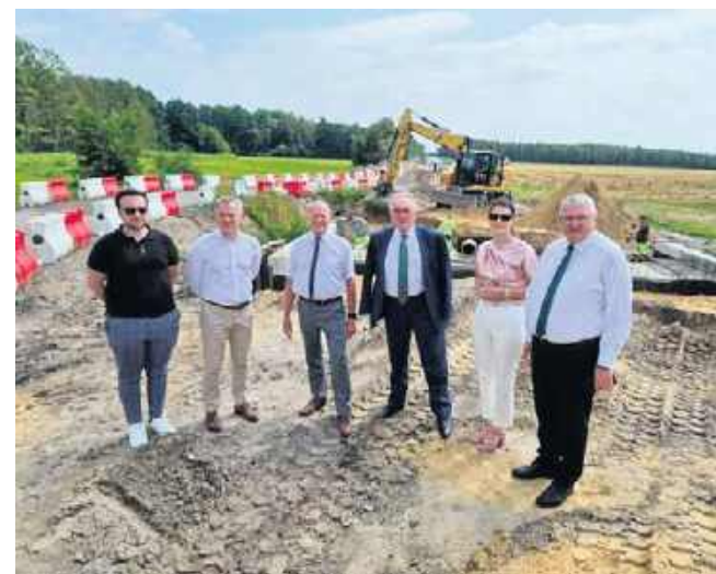
W ramach inwestycji na drodze wojewódzkiej nr 442 przewidziano modernizację 2 odcinków, Chocz - granica powiatu pleszewskiego i Kwień-Chocz.
