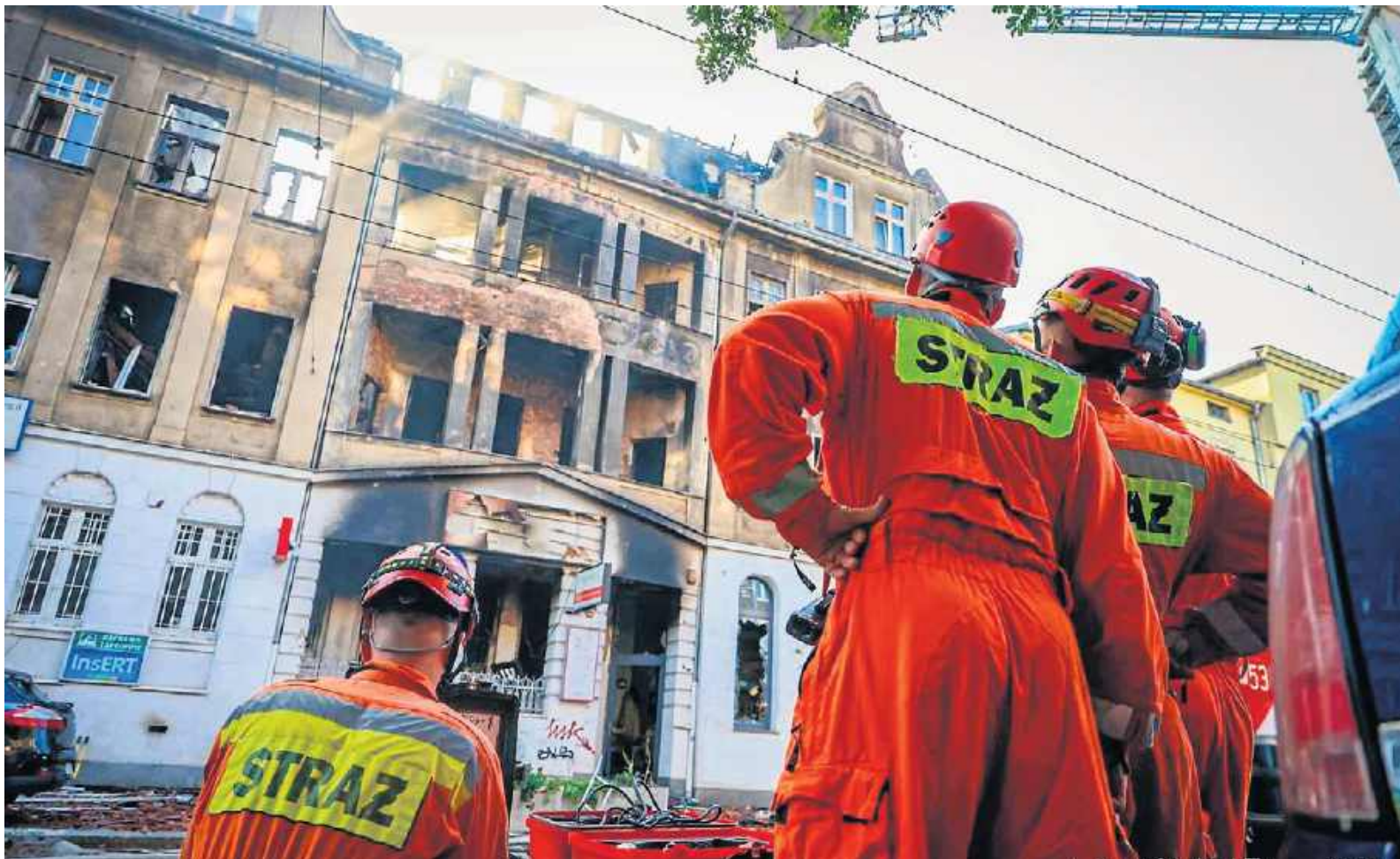
Po wybuchach kamienica na Jeźyczach została rozebrana. Dziś została po niej pusta przestrzeń między budynkami
