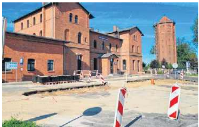
Remont terenu przed dworcem kolejowym w Kowalewie.
