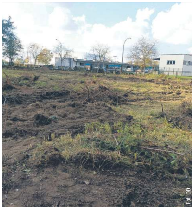
Trwają prace na terenie, na którym ma stanąć lodowisko.
