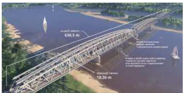
Powrót pociągów pasażerskich na trasę Czachówek Wschodni – Pilawa, nowy most kolejowy nad Wisłą, szybsze połączenia i modernizacja infrastruktury wartę około 1,3 mld zł właśnie zrobili ważny krok naprzód
