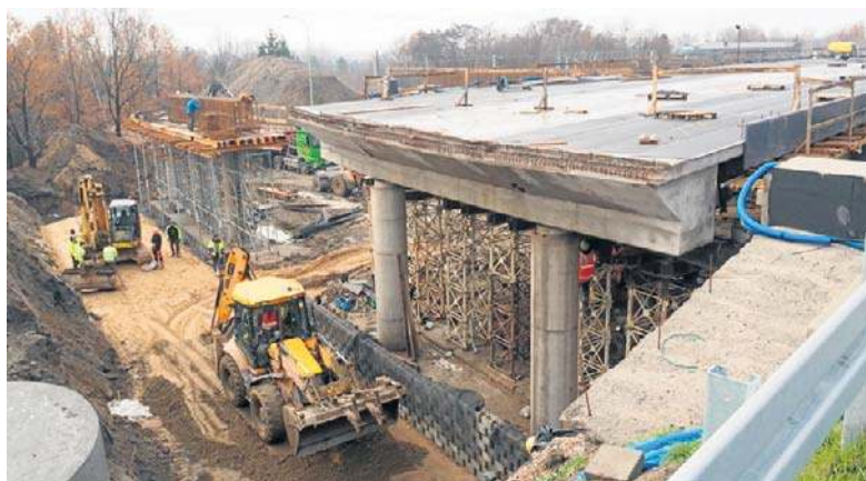
Tak wygląda obecnie budowa wiaduktu na ul. Przybyszewskiego. Miał być gotowy do końca roku
