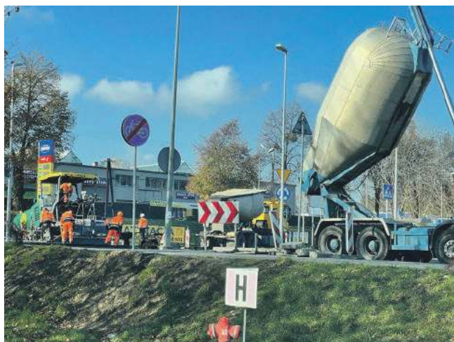
W sobotę zamknięto wjazd na rondo, bo wylewano masę bitumiczną. Niestety budowa nie została jeszcze zakończona
