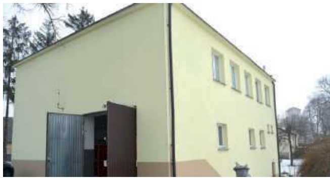
Zgodnie z projektem nowy garaż ma być dobudowany do tylnej ściany remizy na ul. Włostowskiej. Pierwsze prace budowlane będą polegać na wyrównaniu wysokości gruntu, bo dziś za budynkiem widać dołek
