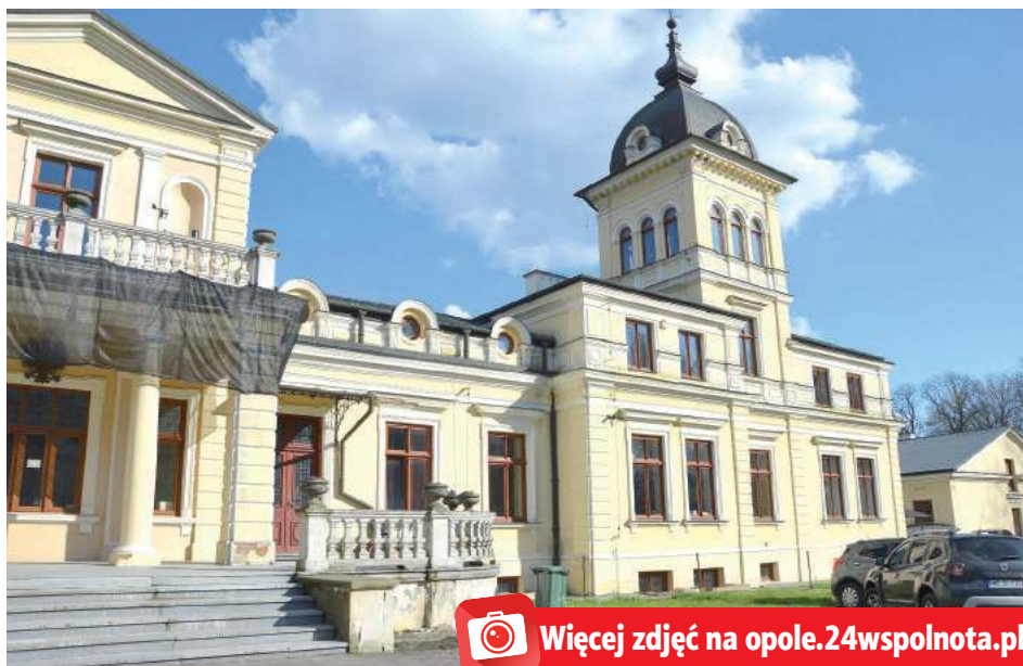
Sam pałac renowację przeszedł kilkanaście lat temu. Ale już wymaga przeprowadzenia kolejnych prac. O naprawę proszą się tynki i detale architektoniczne oraz tarasy
