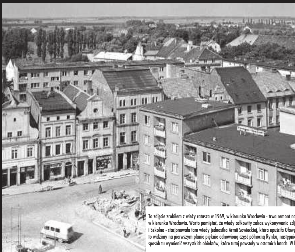
To zdjęcie zrobiłem w 1971 roku - widzimy nierówne ulice z dziurami, które były miesiącami po położeniu nowych instalacji, bo wtedy zasypywano wykopy i czekali, aż ziemia sama osiadzie. Na zdjęciu widzimy, że zaczyna się remont nawierzchni, na której zostanie położony asfalt. Na zdjęciu kolorowym jest nowa nawierzchnia Rynku z kostki brukowej, po lewej stronie wyraźnie widać miejsce, gdzie latem jest fontanna.
