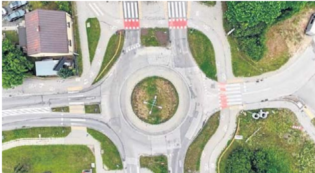
Remontowany będzie odcinek ulicy Warszawskiej od Ronda Geodetów w stronę północną
