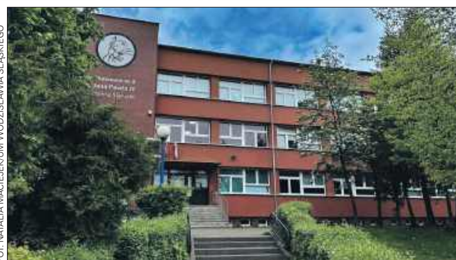
■ Placówki oświatowe po koniecznych remontach są gotowe na przyjęcie uczniów. Na zdjęciu SP3
