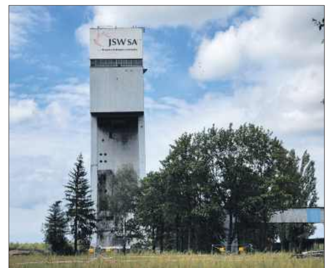
■ Wieża szybowa na kilka minut przed detonacją
