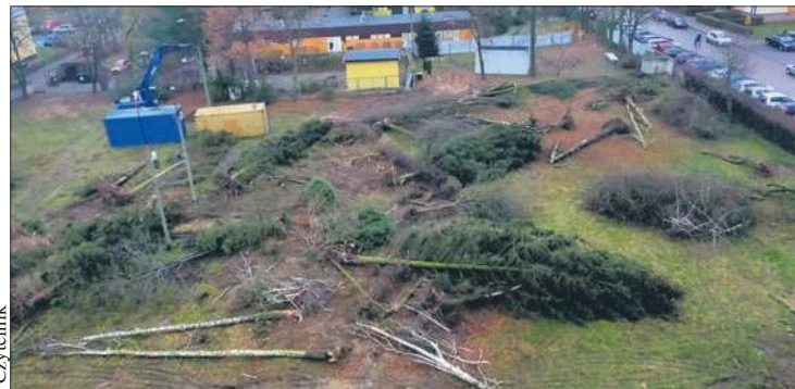
Drzewa wycięte pod budowę nowej siedziby przedszkola nr 17
