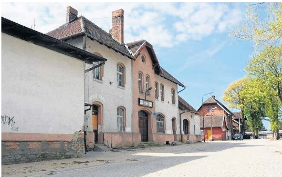
Otoczenie dworca w Łebie zostało wyremontowane ale budynek dworca to rudera. Gmina Łeba go nie przejmie
