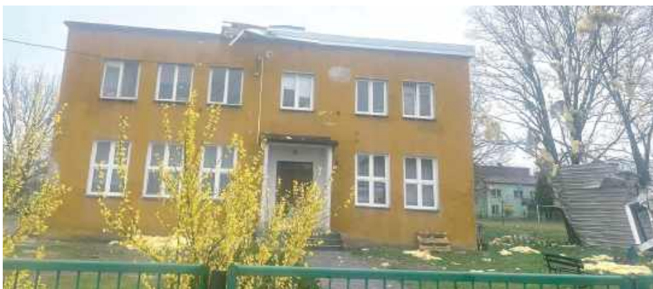
7 kwietnia nawałnica zerwała część dachu na budynku po byłej szkole, a elementy konstrukcyjne spadły na pobliski plac zabaw. Teraz obiekt jest remontowany, radni chcieli sprawdzić, czy legalnie
