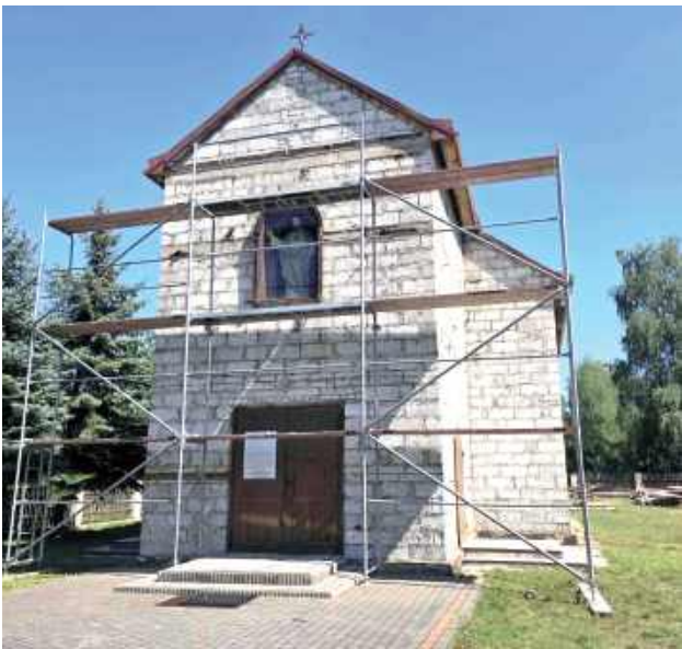
Wartość prac wyniesie 379 tysięcy złotych, a inwestycja realizowana jest przy wsparciu Rządowego Programu Odbudowy Zabytków w ramach Polskiego Ładu
