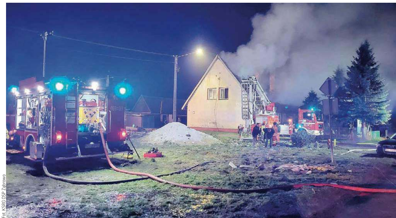
Inspektor nadzoru budowlanego wydał już zakaz użytkowania budynku
