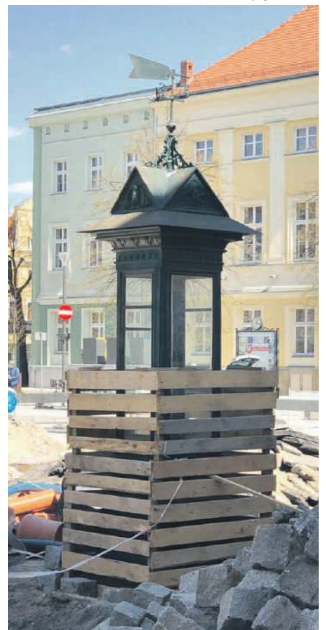
Początek remontu w okolicach obecnej lokalizacji oławskiej pogodynki - 2021
