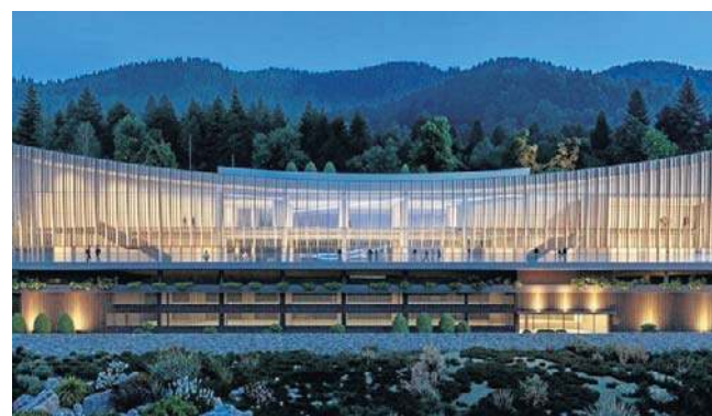
Tak ma wyglądać ten nowy obiekt, który powstanie w sąsiedztwie hotelu Crystal Mountain
