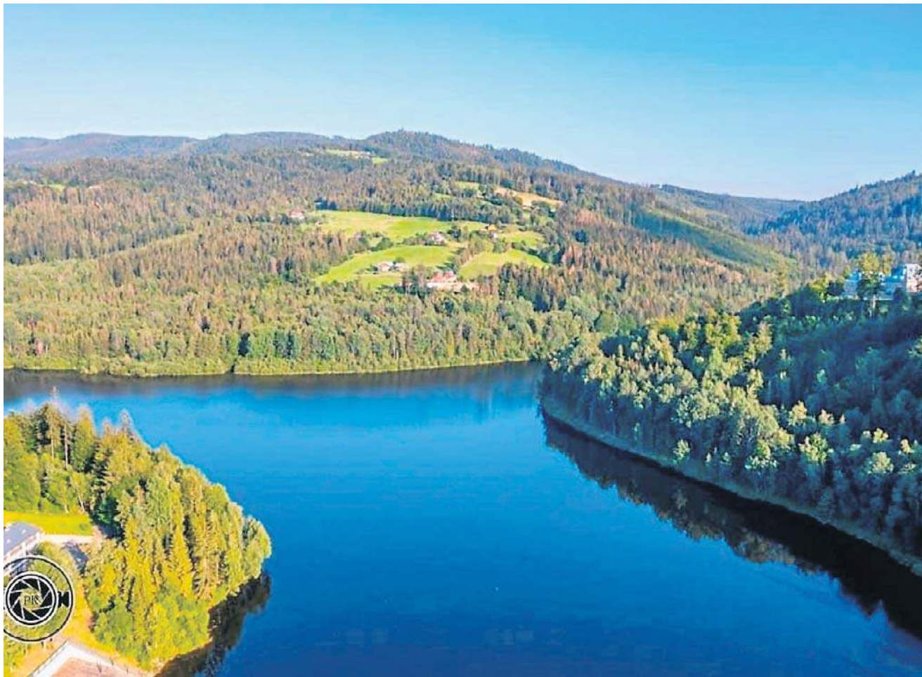
Malowniczo położony zbiornik w Wiśle Czarnem jest systematycznie modernizowany. Kolejne prace już wkrótce
