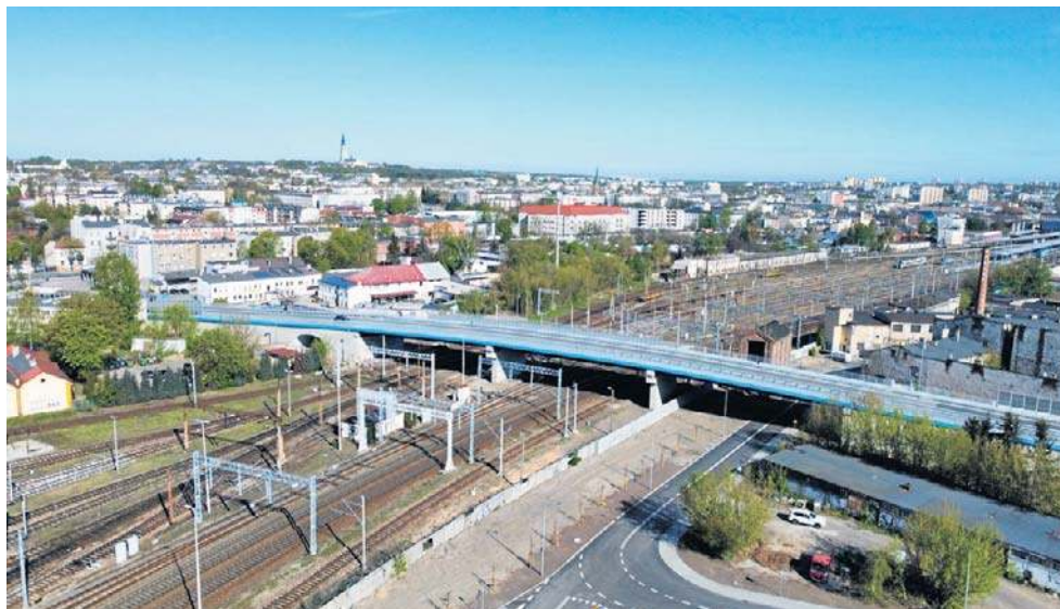
Częstochowa: otwarto nową drogę łączącą DK46 i DK91
