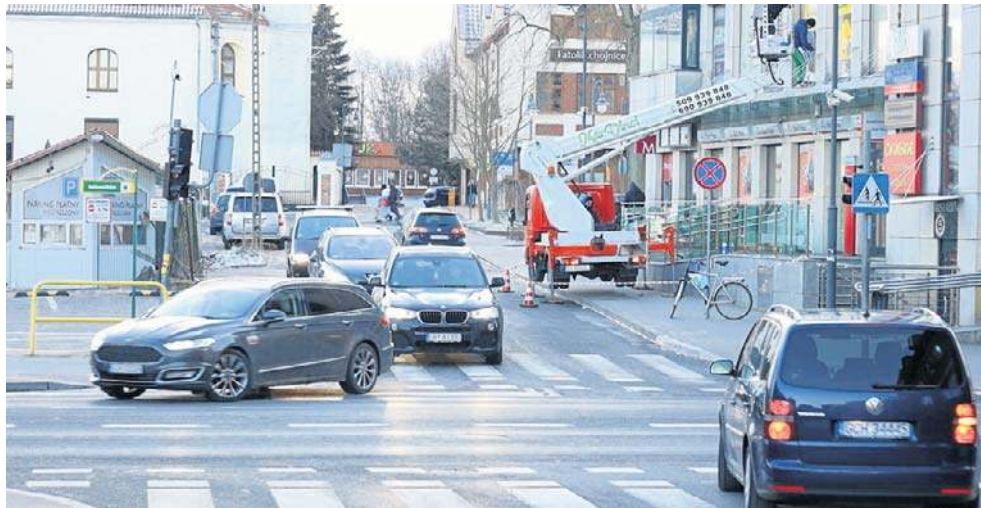
Przy ul. Bankowej w Chojnicach ma powstać aż 130 mieszkań, więc korki są nieuniknione
