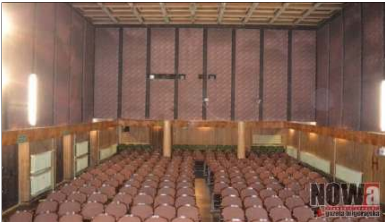
▲ Sala kinowa przed remoncie
