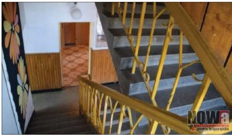
▲ TOK przed remontem
