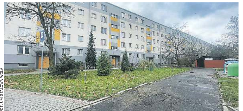
W ramach przebudowy zaplanowano przebudowę ciągów komunikacyjnych, montaż obiektów małej architektury, przebudowę oświetlenia, wykonanie monitoringu wizyjnego oraz nasadzeń
