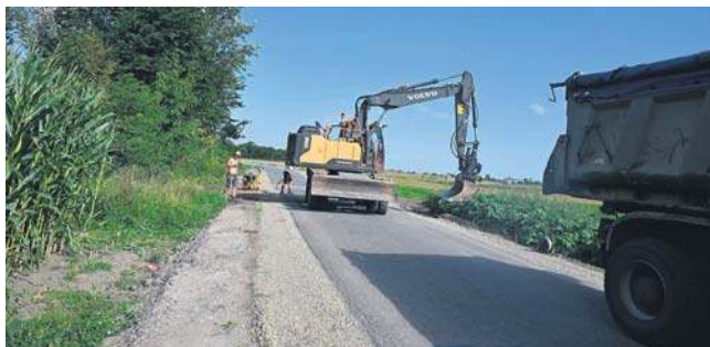
W Siemiradzu w gminie Stara Błotnica trwają prace przy poszerzeniu drogi powiatowej. Zostanie ułożony asfalt.
