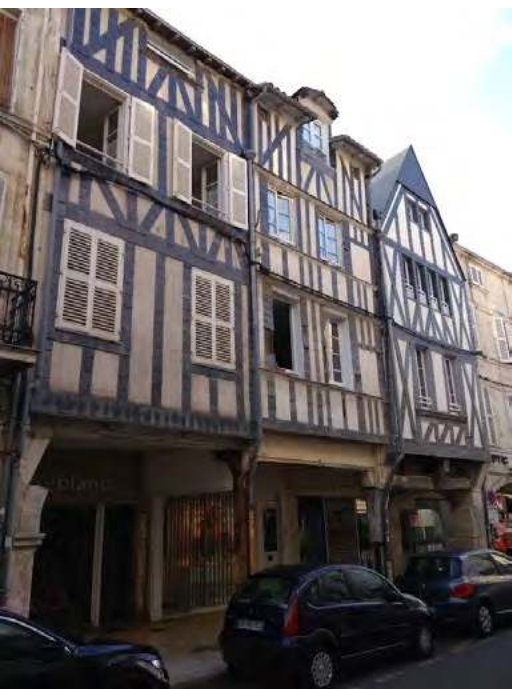
Budynki szachulcowe z drewnianymi elementami konstrukcyjnymi zabezpieczonymi płytkami z tupków
