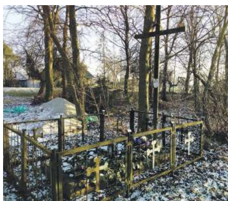
Mogiła przed remontem
