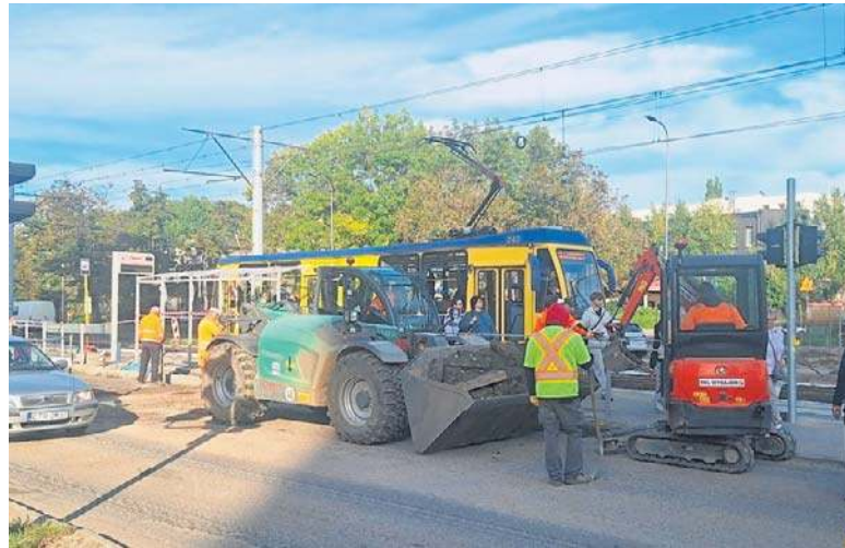
Taki jest stan prac na ulicy Kościuszki - na czwartek 1 października. Potrwają tu one jeszcze przez kilka tygodni
