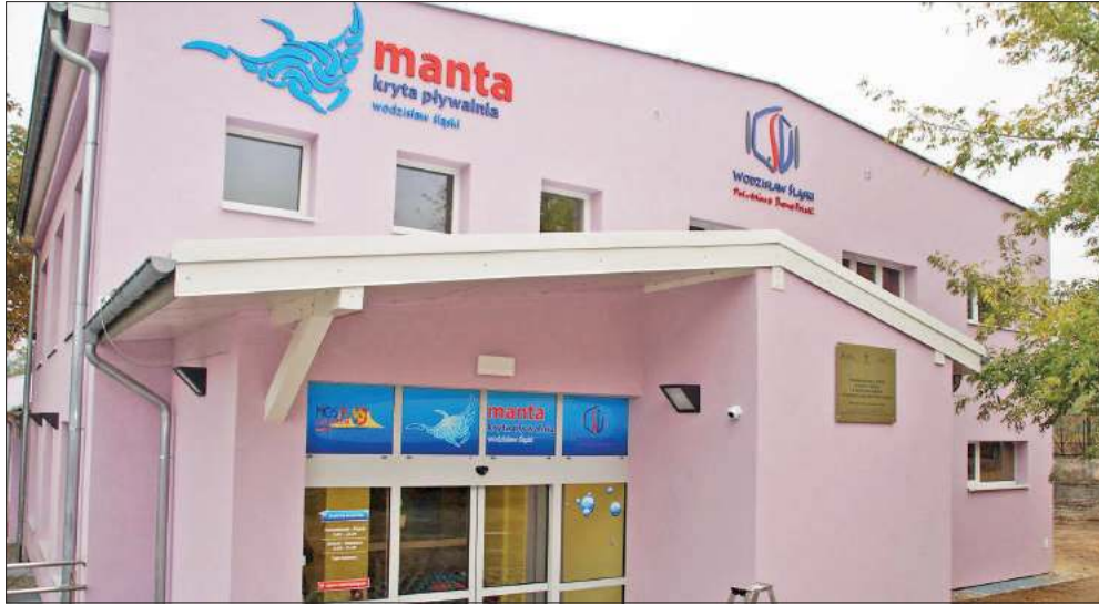
Na dachu Krytej Pływalni „Manta” do końca lipca zostanie zamontowana instalacja fotowoltaiczna
