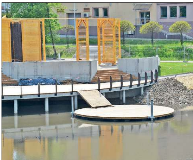
Prace postępują i widać ich efekty. Do wykonania pozostało jeszcze sporo prac.
