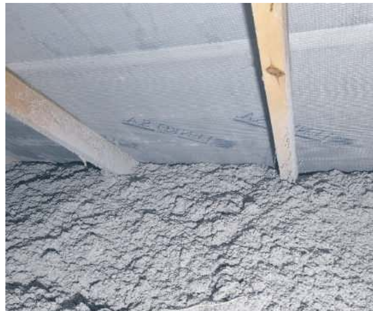
Przed... i po dociepleniu wełną celulozową
