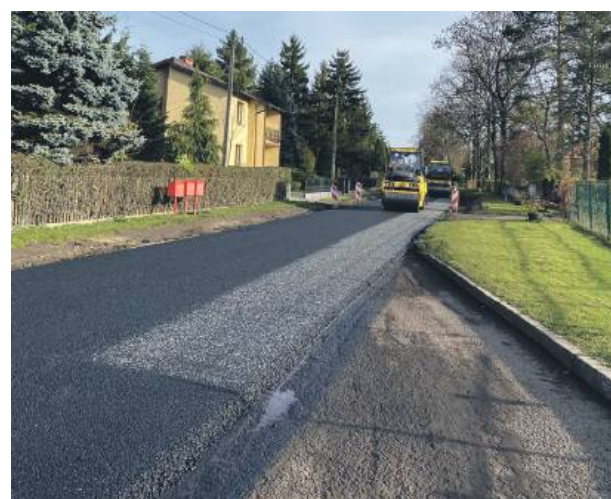
Remont drogi powiatowej w Trzeźni
