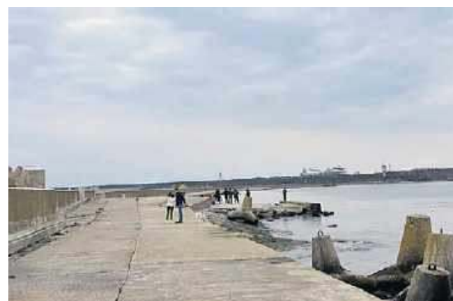
W Świnoujściu są w tej chwili dwa falochrony - tzw. wschodni i zachodni
