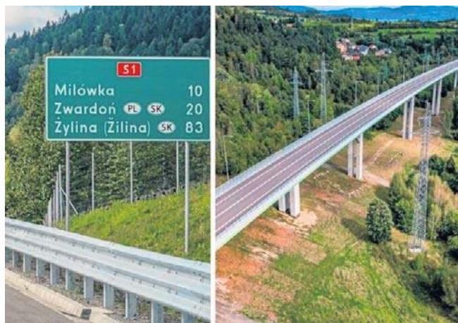
Droga S1. Jutro oddany do ruchu odcinek trasy S1 przecinający Beskidy
