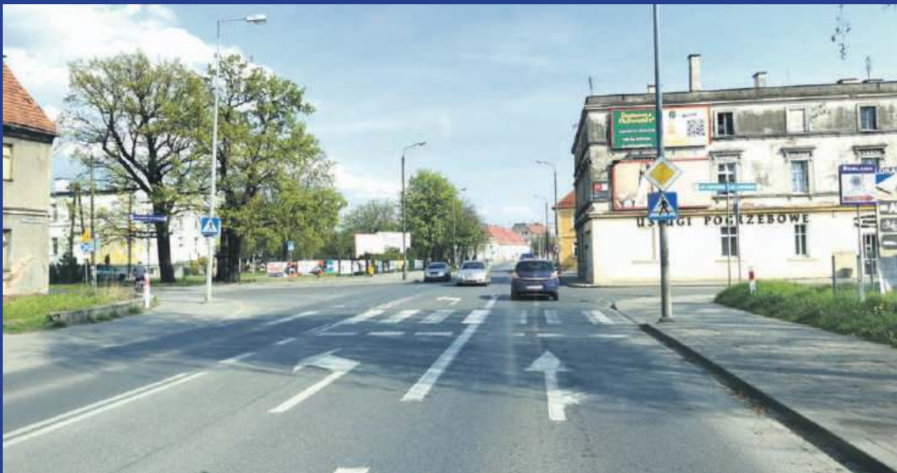
Budowa ronda w tym miejscu ma ruszyć w tym roku. Inwestycja pochłonie 18 mln złotych
