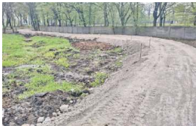
Fragment budowanej ścieżki rowerowej w pobliżu stadionu
