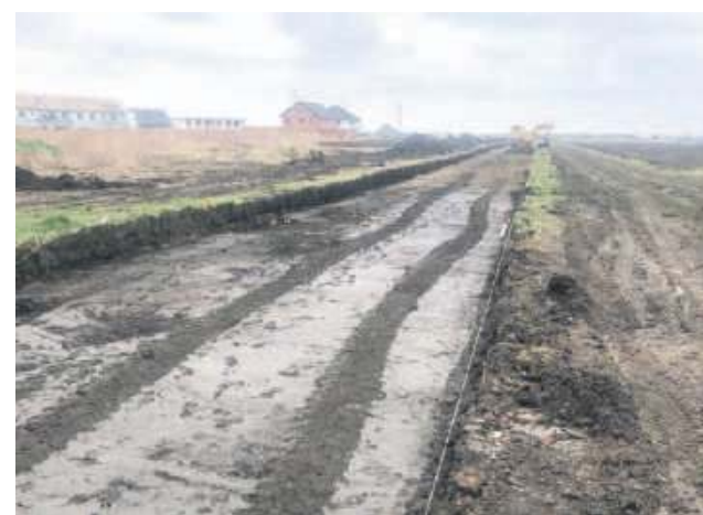
Rozpoczęcie budowy tzw. drogi średnicowej
