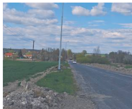
Wola Siennicka - modernizacja oświetlenia ulicznego.
