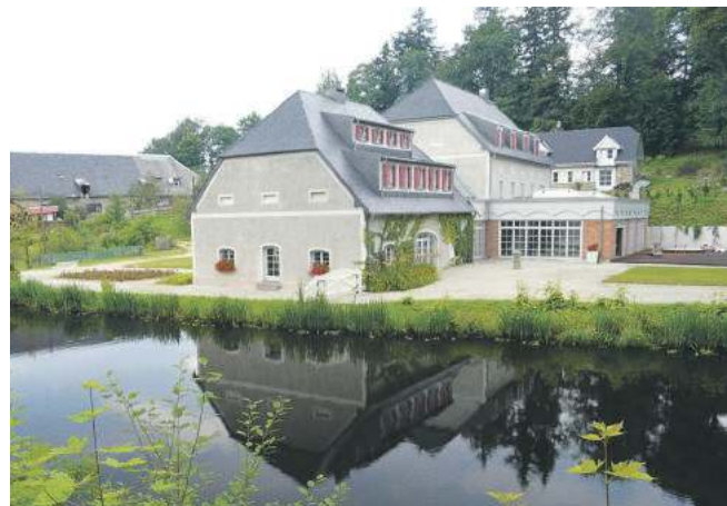
SPA w dawnym budynku gospodarczym pałacu w Stanisławowie
