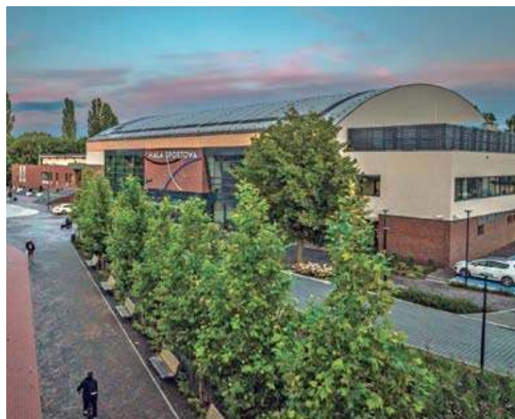
Nowosolska hala sportowo-widowiskowa została Lubuskim Misterem Budowy (fot. Fota z Drona)
