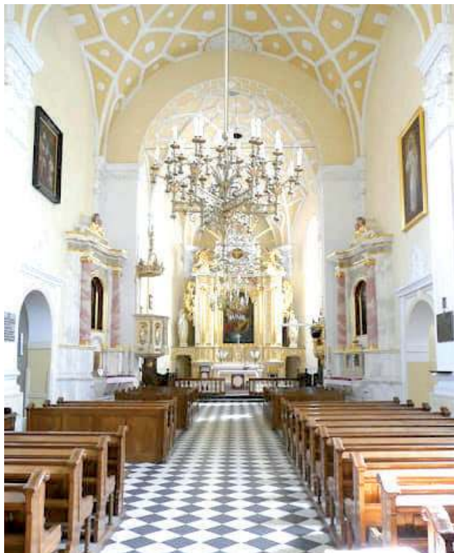
Zakres prac obejmie sztukaterie we wnętrzu kościoła oraz konserwatorski remont ścian. Renowację rozpoczęto od kaplic: północnej – pw. Matki Boskiej Różańcowej oraz południowej pw. Pana Jezusa
