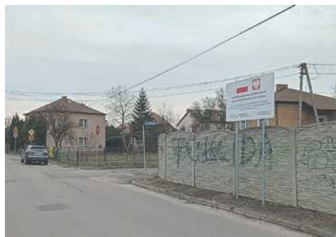
Remontowany ma być 200-metrowy odcinek ulicy Struga
