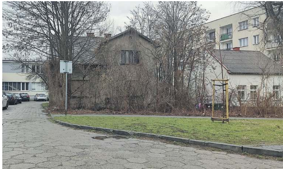
Rudera przy Grzybowej na chrzanowskim osiedlu Północ. Z tyłu przychodnia ZLA
