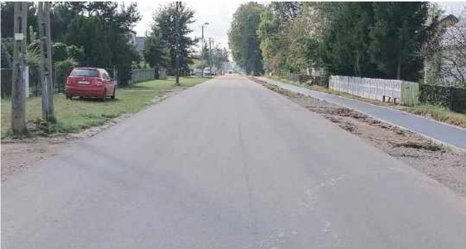
Tak wygląda nowy asfalt. Przebudowany został istniejący chodnik czy zjazdy do posesji
