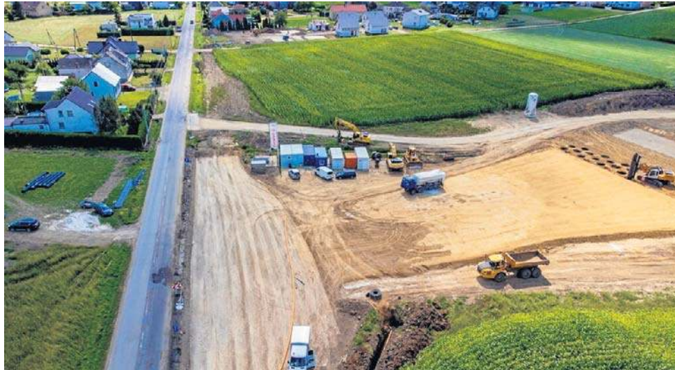
Obecnie prowadzone są prace przygotowawcze związane z budową nowej drogi dojazdowej do mostu od strony Zawady Książęcej w gminie Nędza
