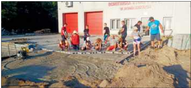
— Starą kostkę zerwaliśmy i daliśmy ją pod spód, żeby bardziej utwardzić powierzchnię — tłumaczy sołtys, Iwona Zieniuk .
