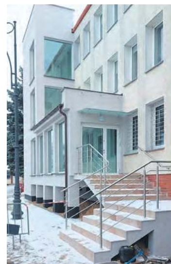
Udogodnień w ramach grantu Dostępna Gmina Cekcyn jest sporo. To najbardziej spektakularne to przebudowa frontu urzędu i montaż windy.
