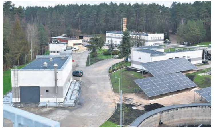
W ramach inwestycji na obiekcie zamontowano instalację fotowoltaiczną o mocy 50 kW, pomieszczenia odświeżono, a teren utwardzono.
