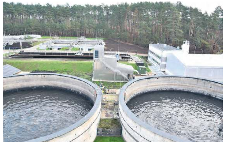
Otwarte komory fermentacyjne po wdrożeniu nowej technologii pełnią funkcję zbiorników retencyjnych.
