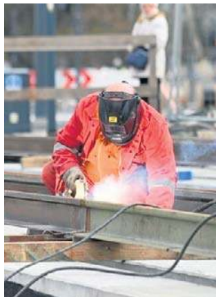
Budowa torowiska na Broniewskiego
