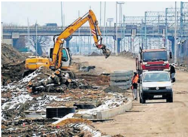
Roboty na budowie nowej trasy N-S w centrum Radomia są już zaawansowane. Mają potrwać jeszcze przez siedem miesięcy.
